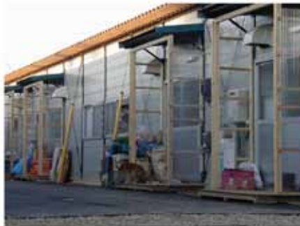
仮設住宅の状況(仮設で犬と共に)
